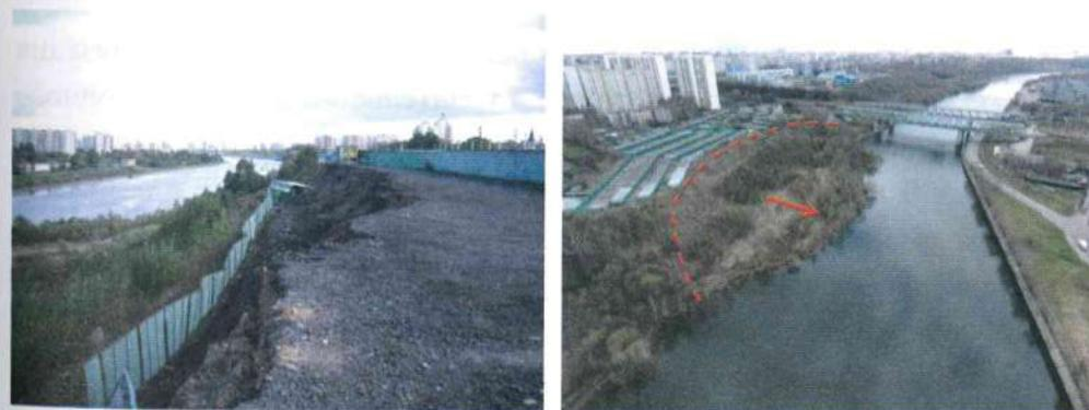
**Рис. 3.7.** Оползневые деформации склона в Москворечье (Москва, 2009 г., фото А.И. Казеева)
